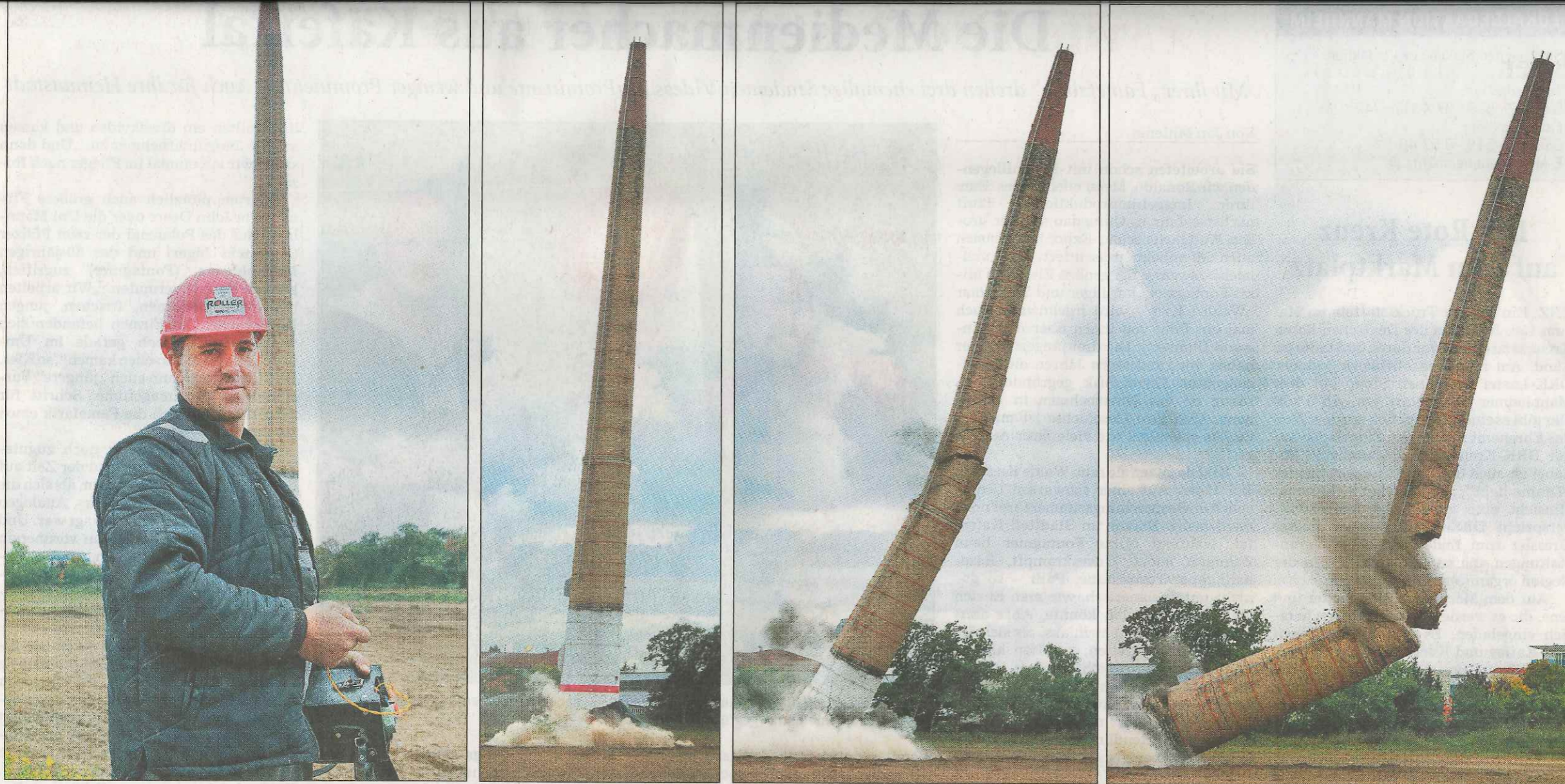
Noch reckt sich der 44 Meter hohe Schornstein stolz den Wolken entgegen. Sekunden später löst Sprengmeister Michael Hamann aus sicherer Entfernung per Knopfdruck die Zündung aus. Fotos: Lenhardt
